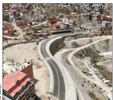
Así se encuentra la vía revitalizada.
