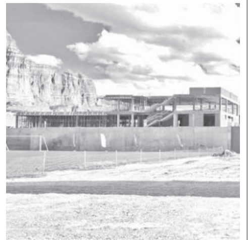
La construcción del complejo. MAS QUE FUTBOL
