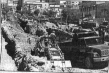
Los trabajos en el Nudo Villazón ahora se dedican a atender el sistema de alcantarillado.
