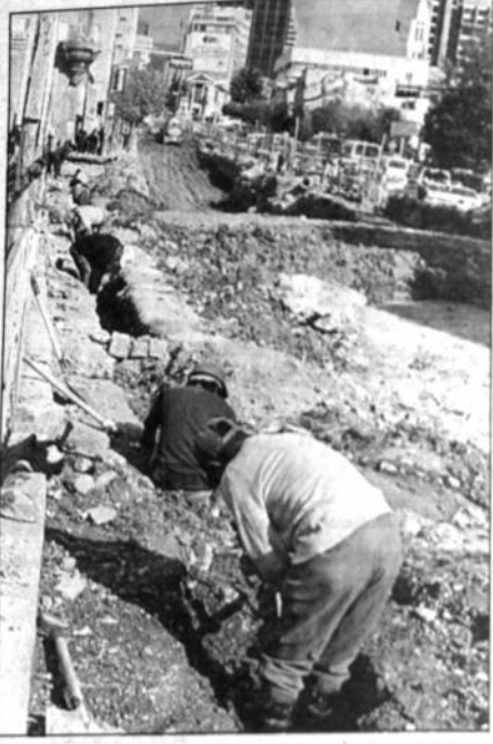
Trabajadores aceleran su labor en el Nudo Villazón, comprendido en las calles Villazón, Aniceto Arce y 6 de Agosto. encuentra en la fase del levantamiento topográfico del lugar. El director de Planificación
