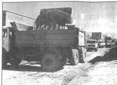
Maquinaria y equipo pesado de la comuna paceña en pleno trabajo de recojo de escombros en dos barrios de la ciudad de El Alto.
