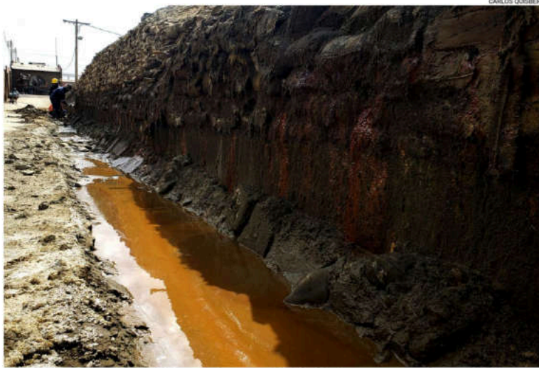
Trabajadores reparan la pared de una de las pozas de lixiviación de una empresa minera en Viacha
