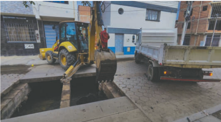
Trabajos de limpieza en el canal Bakovic y sus desarenadores /GAMDO
