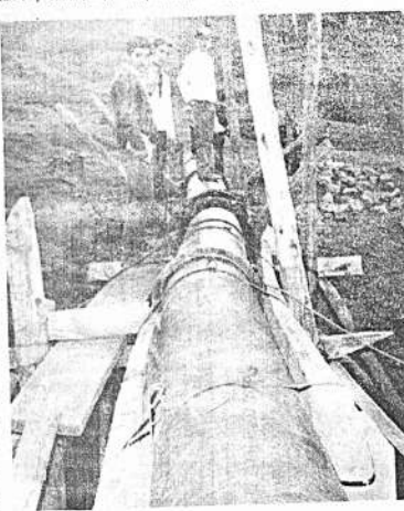
De esta manera, en forma provisional fue repuesta la tubería que suministra agua potable a Sucre. La Empresa de Aguas (ELAPAS) ha pedido una revisión del contrato con la empresa que construyó la tubería.
