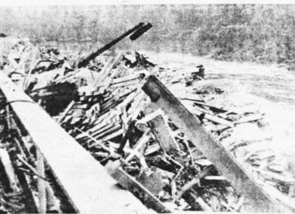
INUNDACIONES.- Rapid City, Dakota del Sur, 9 (AP).- Un encargado de salvataje observa un puente que fuera destruido por las inundaciones en Rapid City, Dakota del Sur. La violencia de las aguas dejó sin hogar a cientos de familias que están recibiendo auxilio de las autoridades del estado. (Radiofoto AP, especial para PRESENCIA)
