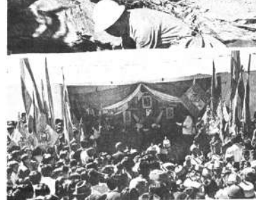
OBRAS PREFECTURALES. La composición fotográfica muestra aspectos de la actual labor prefectural en las obras de caminos y escuelas. Arriba, se ve un equipo humano y mecánico en pleno labor en el camino hacia Mapiri, que tiene proyecciones hasta el Departamento de Pando. Abajo, inauguración de una de las 322 escuelas construidas en el ámbito departamental. Lo de la foto corresponde a una pequeña comunidad cercana a Sucre, Provincia Lurdesa, de La Paz.
