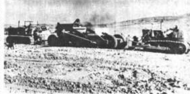
EQUIPO PESADO DE LAS FF.AA. QUE REALIZAN EL MOVIMIENTO DE TIERRAS.
