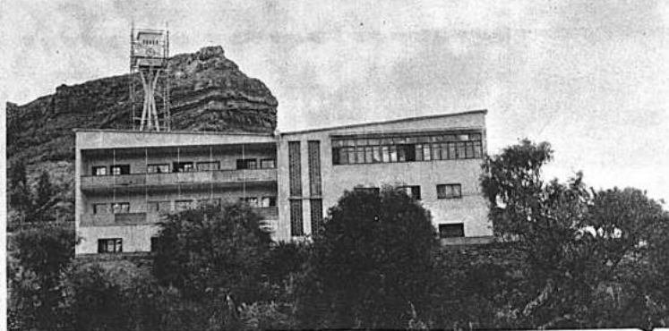
A la mirada del cañón cinteño se alza el moderno edificio de la Clínica "San Clemente" de Camargo. El edificio consta de tres pisos, dos pabellones y 50 camas. Está dotado de modernas instalaciones. Ha sido construido con el esfuerzo del pueblo de Camargo y gracias a la cooperación de la Iglesia Católica, que cumple profusa labor en esa vasta zona.
