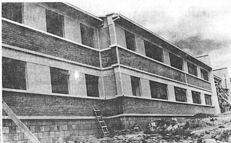
Estado actual de los trabajos del Hospital de la C.N.S.S. en Sucre, dentro de la Unidad Hospitalaria.
