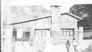
Casa de la Srta. Mercedes Urriolagoitia M., construida por "MARBE THA" S. R. L., entregada 15 - IX - 71 zona del Guero.
