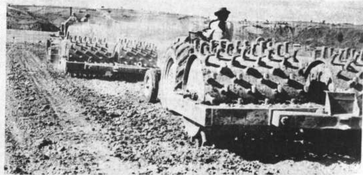
EQUIPO DE COMPACTACION EN PLENO TRABAJO EN ZONAS DE RELLENO
