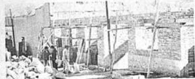
La Alcaldía de Oruro, con la colaboración de los vecinos, construye un centro de abasto en la plaza Walter Khon
