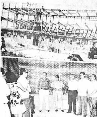
LAS ESTRUCTURAS metálicas que se levantan en el Parque Industrial de Santa Cruz para el primer molino de trigo, disponen además, de una desviación ferroviaria. El molino entrará en funcionamiento en octubre próximo. Abajo: Fernando Bedoya, presidente de "Molineros Bolivianos" y miembro de la Asociación de Molineros de Bolivia, examina el proyecto ante personas ligadas a la actividad agrícola y ganadera.
