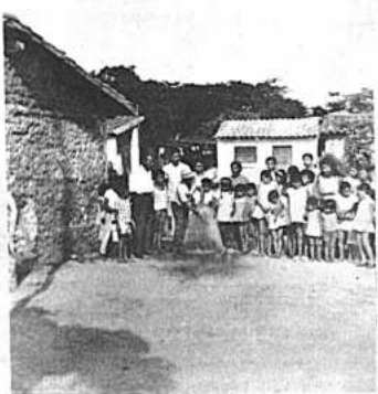
La comunidad vio necesario preservar la salud de la zona. En sus primeros trabajos incluyó la construcción de una posta sanitaria, cuyo local se ve al fondo.
