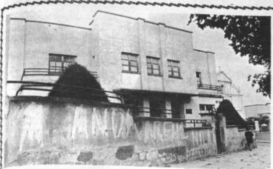
TODO ANTIGUO.- Desde la fachada del hospital en antiguo hace 40 años atrás este edificio era uno de los mejores de la ciudad en la actualidad, para ser habilitado como hospital tiene que ser nuevamente construido.
