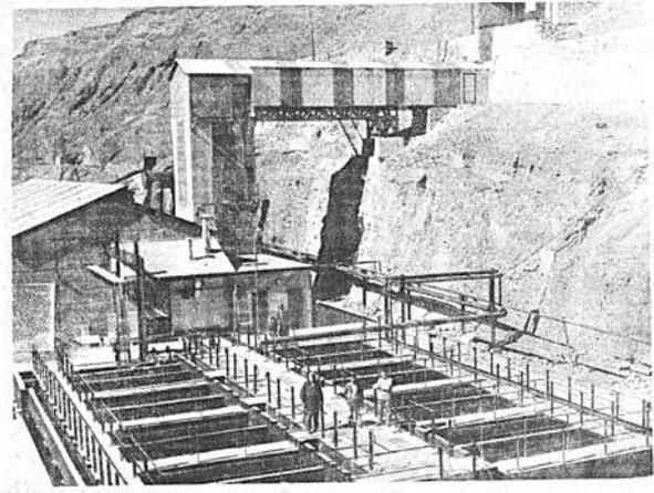
**PLANTA FUNDIDORA DE BISMUTO.** Esta es una vista exterior de la planta de fundición de bismuto que será inaugurada en Telamayo el sábado por el Presidente Banzer. Se observan los sistemas de alimentación de concentrados y los tanques de lixiviación.
