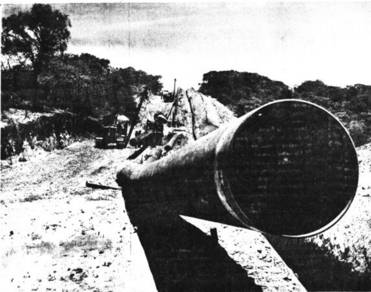
LA TUBERÍA.- El despliegue de esfuerzo humano y técnico para tender el gasoducto culmina hoy con la apertura de las válvulas a cargo del Presidente Banzer. La foto muestra una vista de los trabajos para instalar la tubería de 34 pulgadas en la ruta Colpa - Yacuiba.
