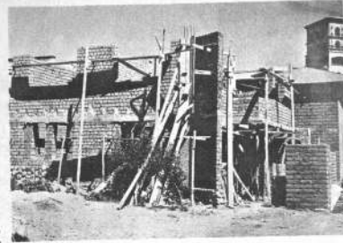
VIVIENDAS.- La Asociación de Ahorro y Préstamo para la Vivienda Potosí se encuentra levantando un edificio multifamiliar en el centro de esa ciudad. El interés que ha despertado esta obra hace que se hayan proyectado nuevas obras.
