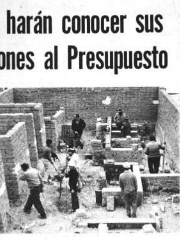
TRABAJOS DE ACCION COMUNAL. El Programa de Acción Comunal de la Municipalidad de La Paz trabaja con los vecinos de las zonas de Alto Miraflores y El Plan de Padrones trabajos de construcción de un moderno mingitorio. La fotografía muestra un aspecto de los trabajos ejecutados.
