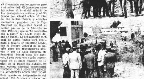
VISITA DE INSPECCION. Ayer en la tarde, el Ministro de Defensa Nacional, acompañado por el Subsecretario de Comunicaciones, visitó las obras de construcción del Hospital Militar.
