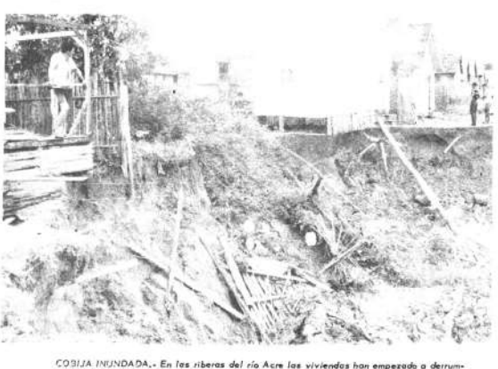
COBIA INUNDADA. En las riberas del río Acra las viviendas han empezado a derrumbarse.
