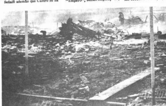
RUINAS.-Orlando Park, 7.-La fotografía muestra a bomberos entre las ruinas de una fábrica de fuegos artificiales Malrose en Orlando Park, Chicago. La planta fue destruida por una serie de explosiones ayer. (Radiofoto AP especial para PRESENCIA).
