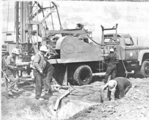
Dos aspectos de los equipos y trabajos para la perforación de pozos destinados a la irrigación del altiplano. El éxito y expansión de estos programas podrían transformar la aridez y clima de nuestras inmensas y félix mesetas.
