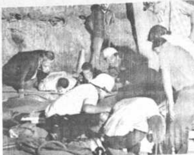
RESCATE.- Monte California, 4.-Mientras el doctor y sus ayudantes conversan con Anthony de 5 años de edad que se ha caído en un pozo de treinta pies de profundidad, los trabajadores escavan paralelamente. Tratando de rescatar a Anthony, en una construcción en el Monte de California, el pequeño Anthony pasó en el pozo 7 horas. (Radiofoto AP especial para PRESENCIA).
