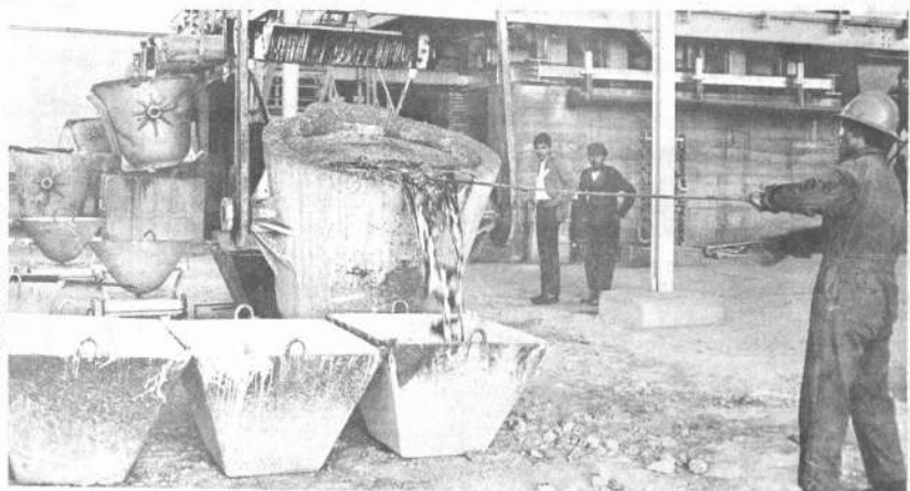
UN OBRERO DE LA EMPRESA NACIONAL DE FUNDICIONES manipula un crisol y vacía el mineral fundido. COMIGOL suministra el 60 por ciento del mineral.
