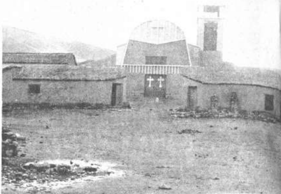
CONTRASTES EN CALA CALA: Las viejas construcciones de adobe no han cambiado nada desde hace 50 o más años, empero el templo ya no es el mismo. La fe de los creyentes de La Paz, Cochabamba y Oruro han hecho posible la construcción del templo que cada 14 de septiembre resulta pequeña para contener los millares de peregrinos que convergen en el Santuario del milagroso Señor de "Lagunas". A poca distancia del templo se encuentran los famosos vertientes que hizo famoso el agua de Cala Cala.
