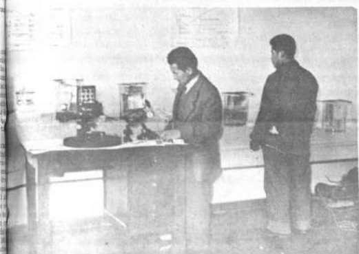
EXPERIMENTOS. El autor de la presente nota, desarrollando experimentos de refinación electrolítica de estaño en el ex-Laboratorio Pírometalúrgico del Banco de Bolivia.
