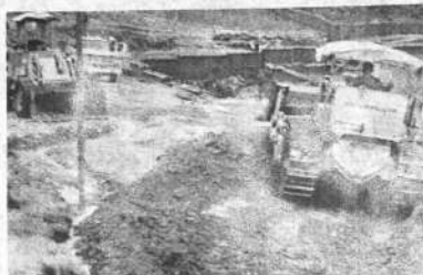
OBRAS PUBLICAS. El equipo pesado de la Comuna de Sucre se encuentra habilitando nuevas vías en dicha ciudad. Se ha mencionado que éste será empleado con una motoniveladora y varias volquetas.
