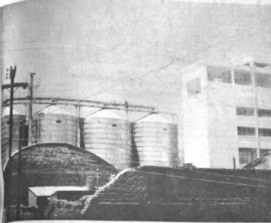
MOLINOS. Con la instalación de cuatro silos para la fábrica de harina de la empresa Ferrari Ghezzi, Oruro se convertirá en el primer Departamento que se abastezca de harina. Los campesinos que cultivan trigo tienen excelentes perspectivas considerando que podrán vender toda su producción a esta empresa. Arriba, se puede observar los imponentes silos con una capacidad total de 2.200 toneladas.
