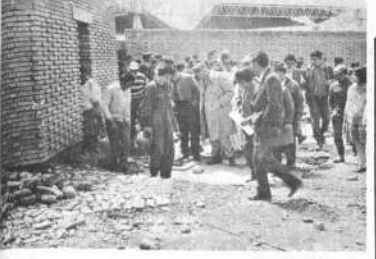
MERCADO VILLA DOLORES: El Alcalde Escobar Uria realizó ayer una visita de inspección a los trabajos que se realizan para la construcción del Mercado de Villa Dolores. El foto muestra un aspecto de la inspección de dicho mercado.
