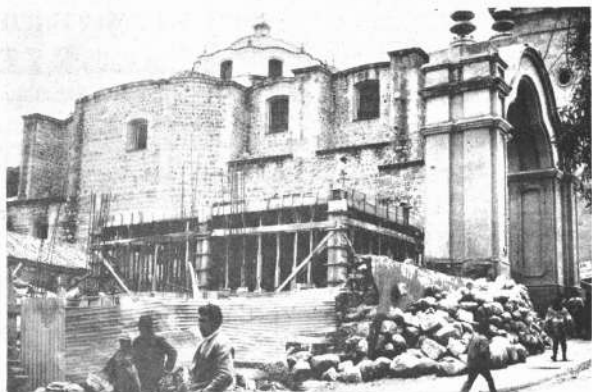
En el atrio lateral de uno de los monumentos nacionales más importantes del país como es la Catedral de Potosí, comenzó la construcción de un edificio moderno.
