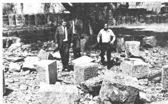
PAVIMENTACION DE LA CIUDAD: La H. Municipalidad adquirió recientemente una buena partida de pasta asfáltica, de procedencia argentina para la ejecución de los trabajos de pavimentación. El titular de la Comuna, Cnl. Germán Lema Araoz observando los trabajos de formación de bloques para los diversos trabajos que se ejecutan dentro los programas de mejoramiento de las calles de la Ciudad de Cochabamba.
