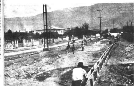
CORDONES DE ACERA EN LA AVENIDA HUMBOLDT: La avenida Humboldt, ribereña oeste del río Rocha, entre los puentes de Cala-Cala y Quillacollo, en una extensión de tres kilómetros, está siendo acordonada en toda su longitud. La Bandeja Central contará con hermosos jardines, embelleciendo una zona importante de la Ciudad.
