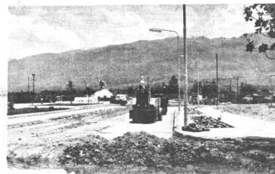
IMPORTANTE NUDO VIARIO: Es el que se ubica en la intersección de los proyectos camineros I y IV de penetración al Chapare, en la zona de la Recoleta, donde se encuentra ubicado el Monumento al Héroe del Topáter don Eduardo Avaroa. Los trabajos se encuentran adelantados y serán entregados al servicio público en los primeros días del mes de enero de 1972.
