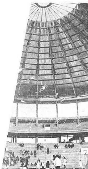
COLISEO TECHADO.- Ya está totalmente techado el coliseo pero todavía no está cerrado por cuanto faltan los vitrales que serán colocados en la parte inferior de la cúpula, como se observa en la foto.
