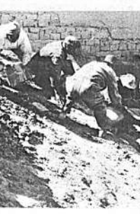
TRABAJOS DE ACCION COMUNAL: Los vecinos de la Tercera Manzana de la zona de Vinto Tinto ejecutando tareas programadas por Acción Comunal en la construcción de un sistema de drenajes.
