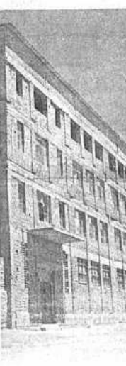
Edificio de la escuela "Virgen del Socavón". Espera la ayuda humana ("divina ya la tiene") para su conclusión.
