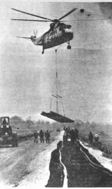
Prisioneros, India, 19 (AP).— Un gigantesco helicóptero bajo un tramo de línea ferroviaria prefabricado en Princeton, Indiana, para conectar a una planta eléctrica. La sección pesa 3,545 kilos y tiene 13 metros de largo. (Radiofoto especial para PRESENCIA).
