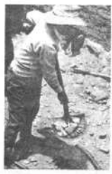
Construcción de diversas obras para beneficio de los barrios.
