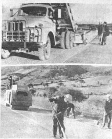
RESELLADO. Dos aspectos de los trabajos de resellado de la carretera Cochabamba-Santa Cruz que serán concluidos en el mes de mayo próximo. Personal y equipo se destinaron luego a la rehabilitación del camino Santa Cruz-Montero.
