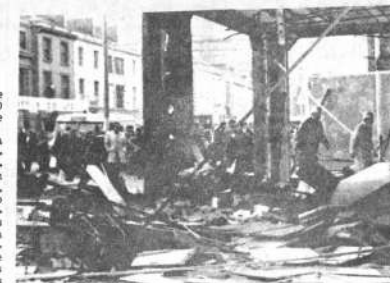
EXPLOSION. Belfast, Irlanda del Norte 1 (AP). - Una multitud se reúne para ver las consecuencias del estallido de una bomba de tiempo, en el centro de Belfast, el lunes. La explosión hirió a seis personas que caminaban por el centro, en el momento de mayor afluencia. Un empleado dijo que dos hombres armados con pistolas entraron en el edificio donde estaba la bomba. Los hombres habrían dicho "¡ustedes tienen cuatro minutos para salir ahora!". (Radiofotografía, especial para PRESENCIA).
