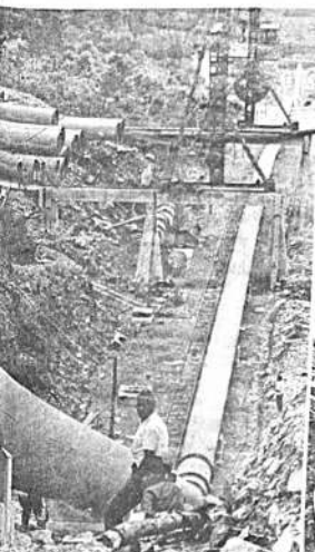
Distintas etapas de la colocación de la tubería, a la derecha se puede observar la línea de transporte.
