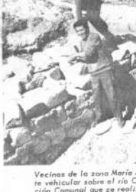
Vecinos de la zona María Auxiliadora construyen un puente vehicular sobre el río Cota Huina en la jornada de Acción Comunal que se realizó ayer.
