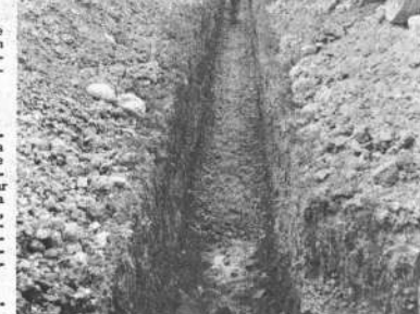
La Alcaldía Municipal de Tarija ha iniciado la ampliación de la red de alcantarillado de esa ciudad. La fotografía muestra los trabajos que se realizan.
