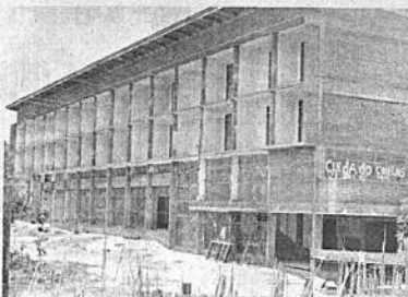
2,100,000 pesos se necesitan para concluir el Hotel de Turismo de Tarija, que aparece en la fotografía a medio construir.
