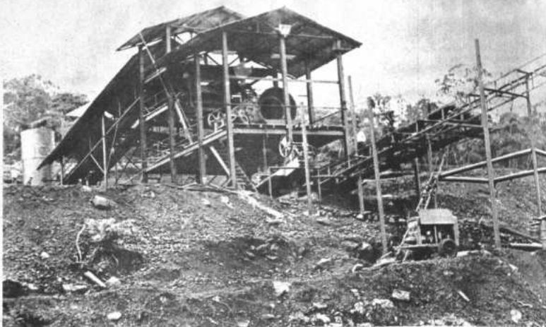
Mutún, palabra que se convirtió en un anhelo nacional, actualmente se viene convirtiendo en una realidad. La Corporación Minera de Bolivia a través del esfuerzo de 75 técnicos y obreros está trabajando en las gigantescas yacimientos de hierro para convertirlos en una fuente de producción que colabore al engrandecimiento del país.
