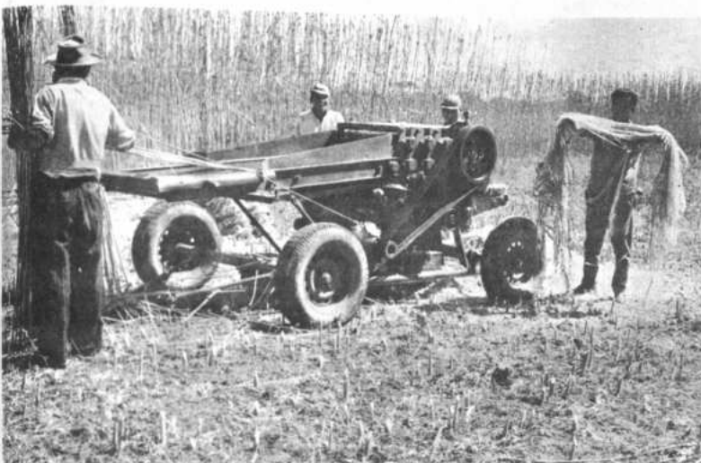
En la elaboración del hilo y tela que es utilizado para envases y otros derivados, la mecanización es un factor importante para las rendiciones más eficientes. En el gráfico se observan a cuatro operarios trabajando en una máquina desecadora.
