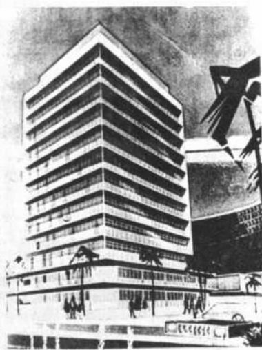
EDIFICIO "SANTA CRUZ" Esquina Velasco y Ayacucho
