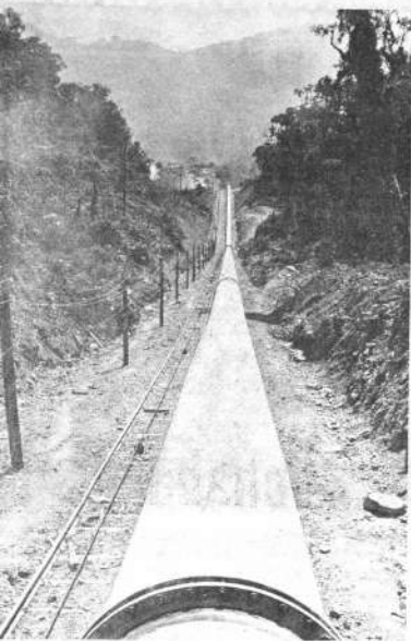
La tubería blindada que llevará el caudal necesario para el funcionamiento de las turbinas. Hasta ahora se encuentra el 50% de la tubería. Vale decir 1.500 metros
