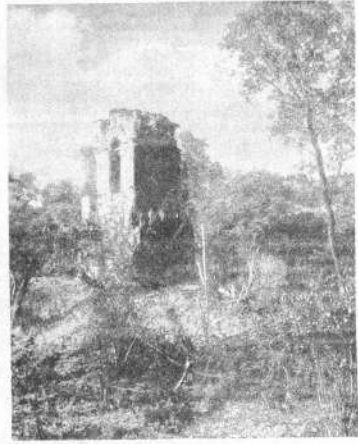
Ruina de la Iglesia del antiguo pueblo Quetama
