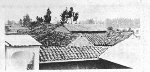
Los techos de la mayor parte de las viviendas de Arani son de tejas, algunas han a - duntado la calamina
