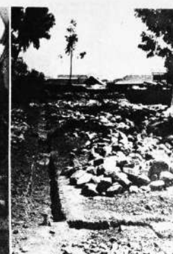
Así será construida la unidad escolar
