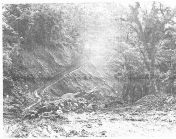
El terreno desmenuable y las permanentes lluvias dificultan el avance de los trabajos en la zona denominada "Abra del Sillar". El lugar se encuentra a los 700 y 1700 metros.
