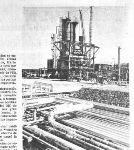
En la fotografía aparecen las obras de ampliación de la refinería de petróleo de Cochabamba. Previamente, la ampliación garantiza el abastecimiento de combustible para el país por un período de seis a siete años.
