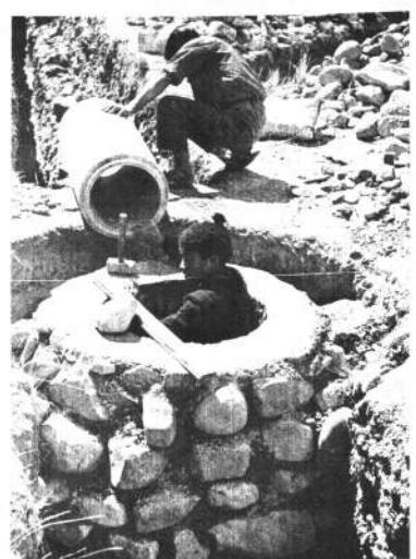
Los trabajos de alcantarillado sanitario y pluvial de la urbanización de Río Seco se encuentran bastante avanzados. En la fotografía se observa una cámara de inspección de la red de alcantarillado y las tuberías que están siendo colocadas. Dicha urbanización tendrá 192 viviendas destinadas a trabajadores fabriles.
