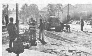
Trabajos en la plaza y calles principales de la localidad de Quillacollo, a cargo del organismo de desarrollo de la localidad.
