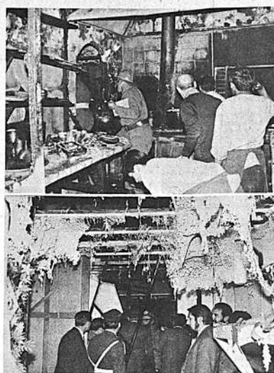
Aproximadamente a las 14.30 horas de ayer, en la cocina del restaurante "Maxim's", ubicada en el segundo piso del inmueble No. 1557 de la avenida 16 de Julio, se produjo un incendio sin desgracias personales.
