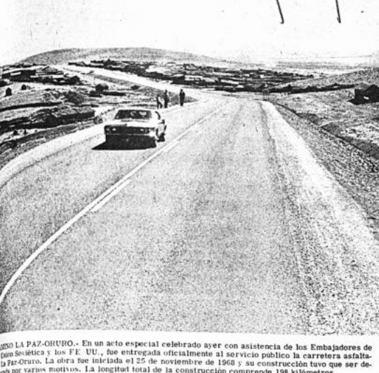
LA PAZ-ORURO. En un acto especial celebrado ayer con asistencia de los Embajadores de la Unión Soviética y los EE. UU., fue entregada oficialmente al servicio público la carretera asfaltada La Paz-Oruro. La obra fue iniciada el 25 de noviembre de 1960 y su construcción tuvo que ser detenida por varios motivos. La longitud total de la construcción comprende 198 kilómetros.
