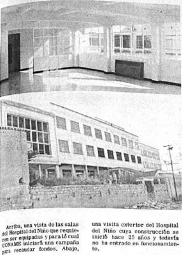
Arriba, una vista de las salas del Hospital del Niño que requieren ser equipadas y para lo cual CONAME iniciará una campaña para recaudar fondos. Abajo, una visita exterior del Hospital del Niño cuya construcción se inició hace 25 años y todavía no ha entrado en funcionamiento.
