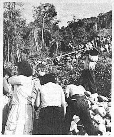
La Corporación de Aguas Potables y Alcancillado (CORPAGUA), iniciará próximamente la ejecución de tres importantes obras de construcción en las localidades de Guayqui, Vallegrande y Villa Tunari. De acuerdo a un informe dado a la población, la población de Guayqui, recibirá un pago de 70 litros por día por cada habitante, que será captado de la quebrada de Guayquini.
