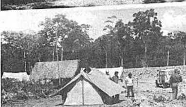
Trabajos de movimiento de tierra en plena selva en la región de Juen Retiro; el ferrocarril Mamoré se aproxima al río Yacani. Abajo: Un camión ferroviario movilizándose conforme avanza la forestación.
