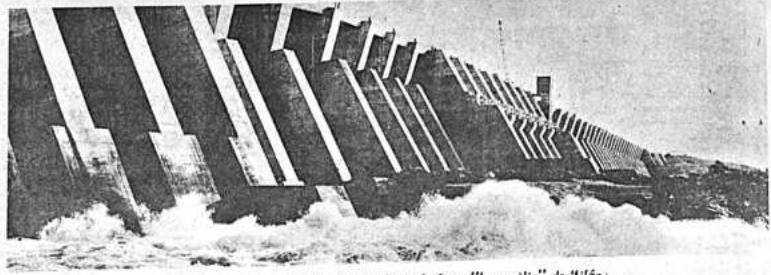
Dique de Roseires en Sudán, construido por la firma "Impregilo" de Milán.
