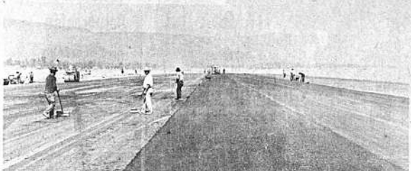
ASFALTADO.- Recientemente fueron iniciados los trabajos de asfaltado de la faja principal de aterrizaje del aeropuerto "Jorge Wilsterman" de la ciudad de Cochabamba. Las obras son ejecutadas por los técnicos y trabajadores de la Corporación Boliviana de Fomento, institución que adquirió maquinaria adecuada para ejecutar estos trabajos de ampliación y modernización de la terminal aérea de la capital cochabambina. Las obras se iniciaron el pasado 17 de noviembre como consecuencia del contrato suscrito entre el Ministerio de Transportes y Comunicaciones y la empresa constructora Barios. Esta institución contrató a su vez los servicios de la CBR. La capa de nivelación que actualmente se coloca en la pista principal del aeropuerto tiene un espesor de 20 centímetros en algunos sectores. Más adelante se le añadirán otras dos capas hasta lograr el soporte necesario para el aterrizaje y operaciones de modernas máquinas Boeing. Los trabajos de modernización de la terminal aérea de Cochabamba, que tienen un presupuesto de 14,209,323 pesos, se entregarán a fines del presente año.
