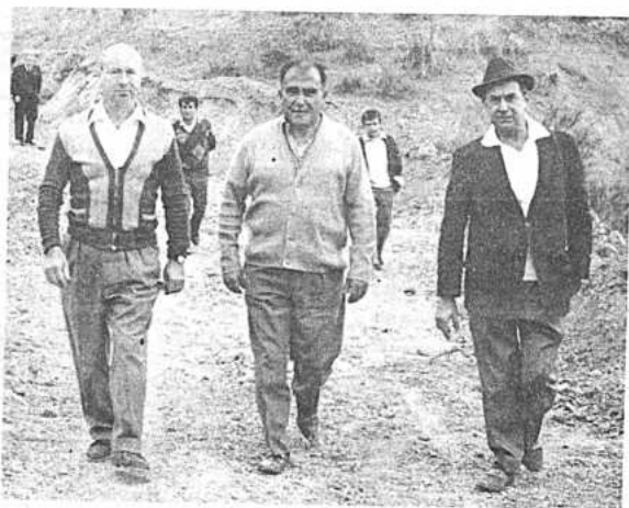
El Alcalde Municipal de Chuquisaca, Cnl. Salvador Sanchez Vargas en una inspección de obras de la que sería luego la plan- ta purificadora de agua, es acompañado por el consultor de la Sociedad SEUREKA Ing. Raoul Imbert, (izquierda), y el delegado de la Sociedad DEGREMONDT Ing. Raymond Murys, ambos téc- nicos franceses.
