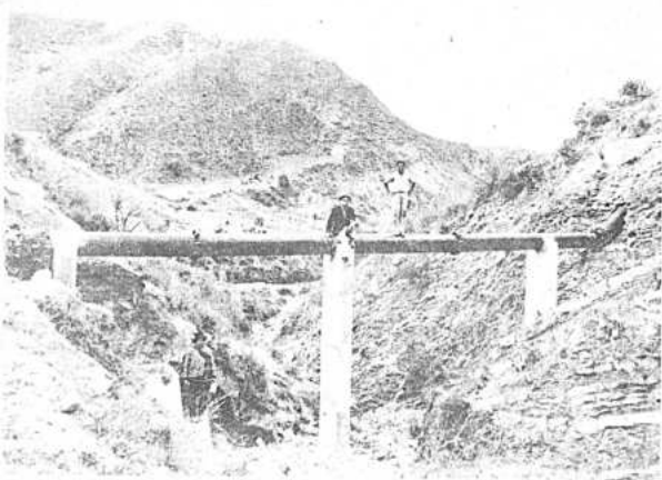
Por zonas sin vías de comunicación y de difícil acceso y a lo largo de 8 kilómetros, construyendo caminos y senderos, se ejecutó los trabajos de tendido de tubería de 400 mm. de diámetro para llevar el agua a tratarse en la planta de EL ROLLO.
