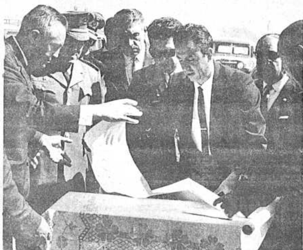
Iniciación de obras.- La secuencia corresponde al acto de iniciación de obras en fecha 17 de Mayo de 1969 en la que se destacan los ingenieros de SICSA explicando detalles del proyecto a las autoridades del departamento.
