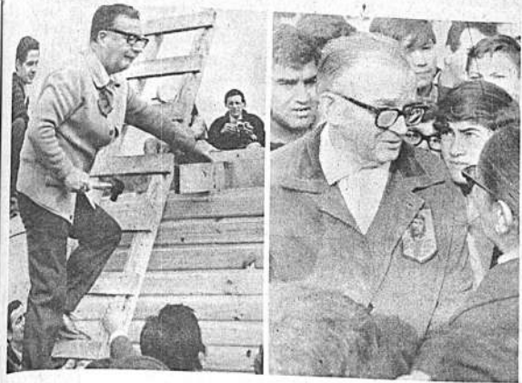
"DÍA NACIONAL DEL TRABAJO". El Presidente Salvador Allende martilla una viga en el techo de su casa, en un barrio de indigentes en Chile. A la derecha, Ernesto Guevara Lynch, arquitecto argentino, padre del desaparecido jefe guerrillero Ernesto "Che" Guevara, que participó en el primer día nacional de trabajo voluntario. (Radiofot AP, 16, especial para PRESENCIA).
